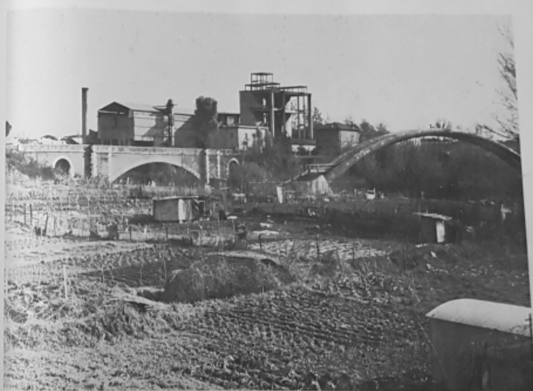
Via di Salvo, ponte all'Arno
