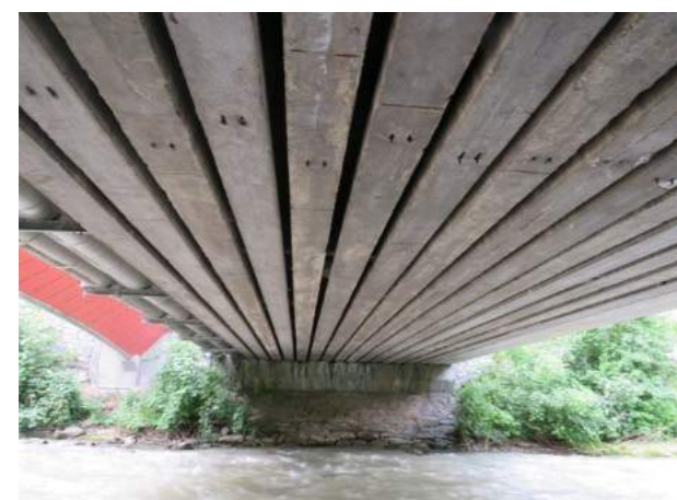
Fig. 6 -Esempio di impalcato in calcestruzzo
