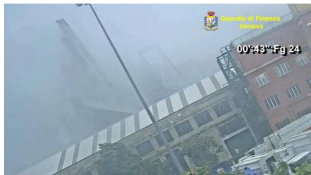
Foto 34. Scomparsa improvvisa antenna nord
