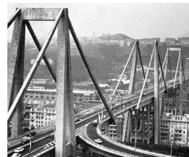
Fig. 2 - Viadotto sul Polcevera, Genova, 1963-1967
