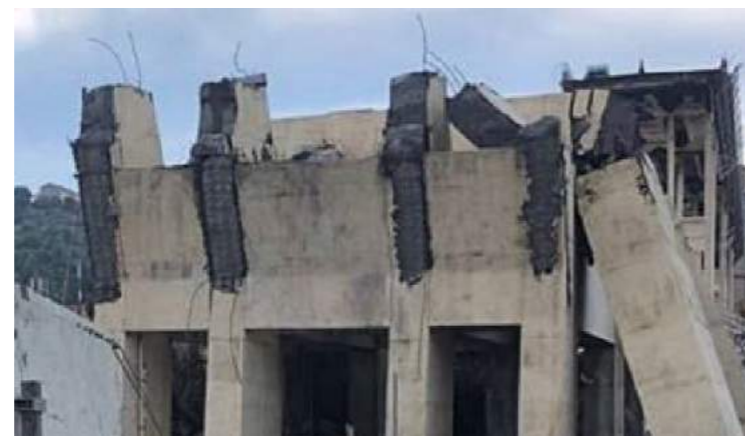
Foto 7. Particolare ferri di armatura rivolti verso l'alto
