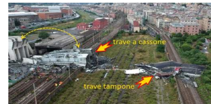
Elementi crollati sui binari; a sinistra, la parte di trave a cassone finita sottosopra; a destra, la trave tampone
