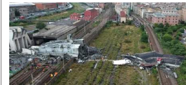
Foto 9. campata cappottata per il lungo e monconi pilastri in alto; all'angolo in alto a destra si vede estremità pila 10
