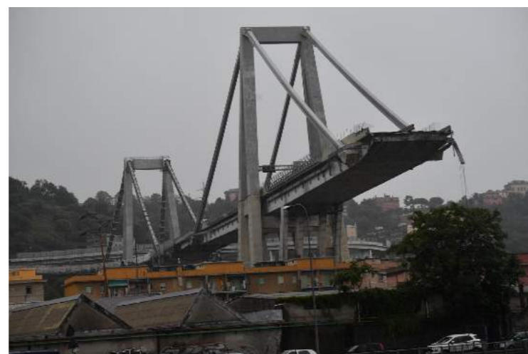
Fig. 6 - Foto della parte di viadotto non interessata dal crollo del 14.08.2018
