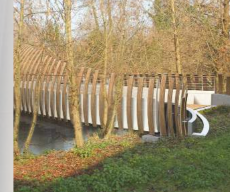
FOOTBRIDGES Rofas (Tv)
