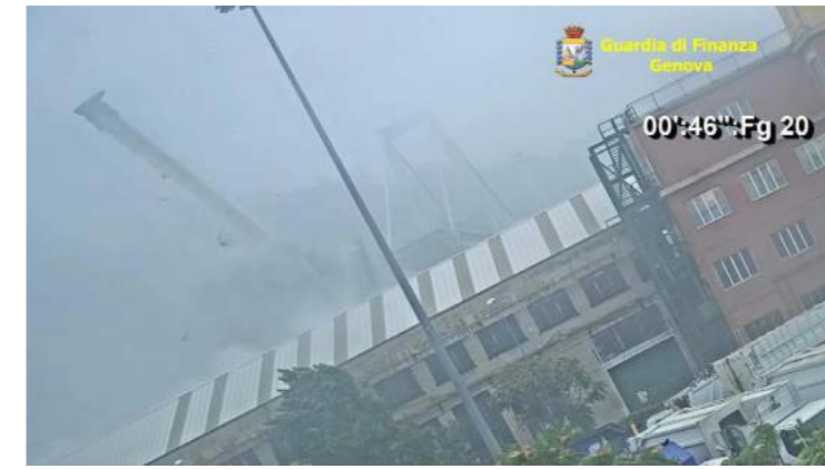
Foto 39. Pilastro ritorna dritto in asse con la base
