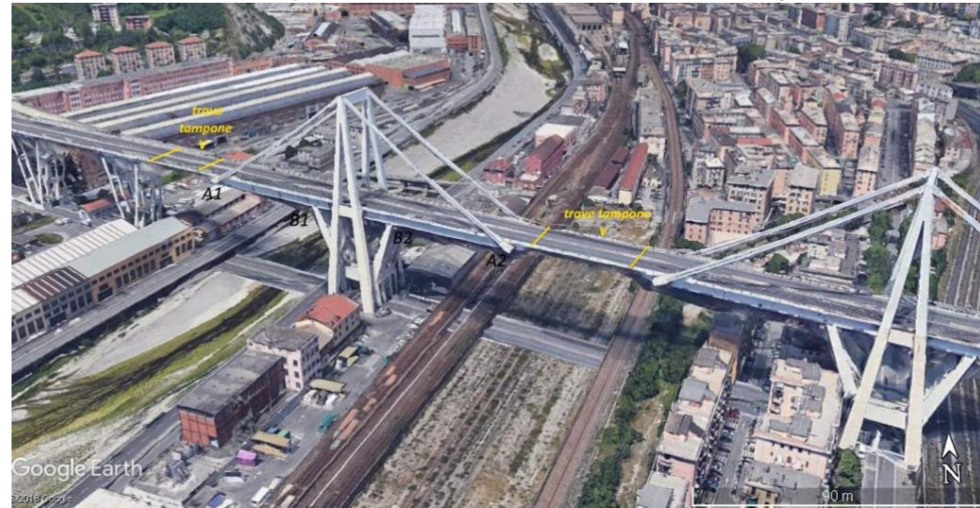
Le due "travi tampone" tra le selle gerber crollate con la pila nove e la "trave a cassone" dell'impalcato, a tre campate, sorretta sia dagli appoggi estremi (A1 e A2, costituiti dagli "stralli") sia dagli appoggi intermedi (B1 e B2, costituiti dalle "saette" del cavalletto ad "H") che cedendo potrebbero aver incrementato le sollecitazioni sull'impalcato poi crollato.
