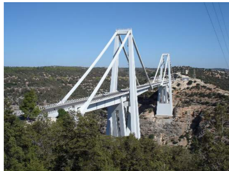
Fig. 4 - Viadotto di Wadi al-Kuf presso Beida, Libia, 1967-1971
