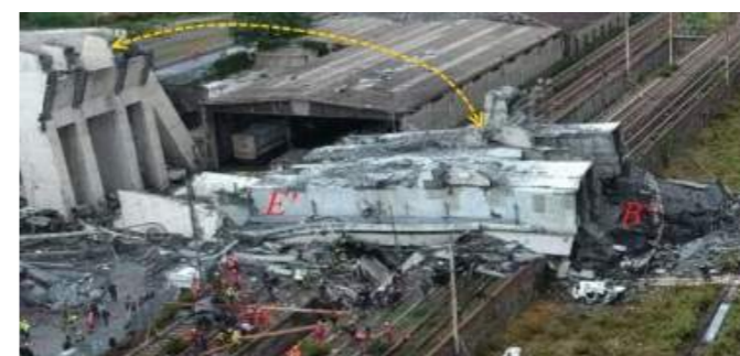
Particolari della parte di trave a cassone finita sottosopra: ossia ruotata di 180° attorno all'asse trasversale del viadotto.
