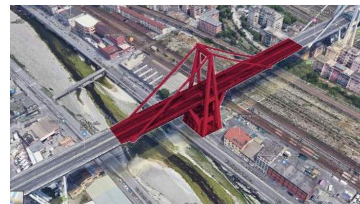
Fig. 28 - In rosso evidenziata la PILA 9 - del Ponte sul Polcevera di Riccardo - collassata il 14/08/2018- Rif. lavocedigenova.it
