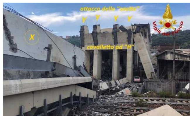
X: tratto B'E' ruotato di 180°; Y: punti di rottura "saette"
