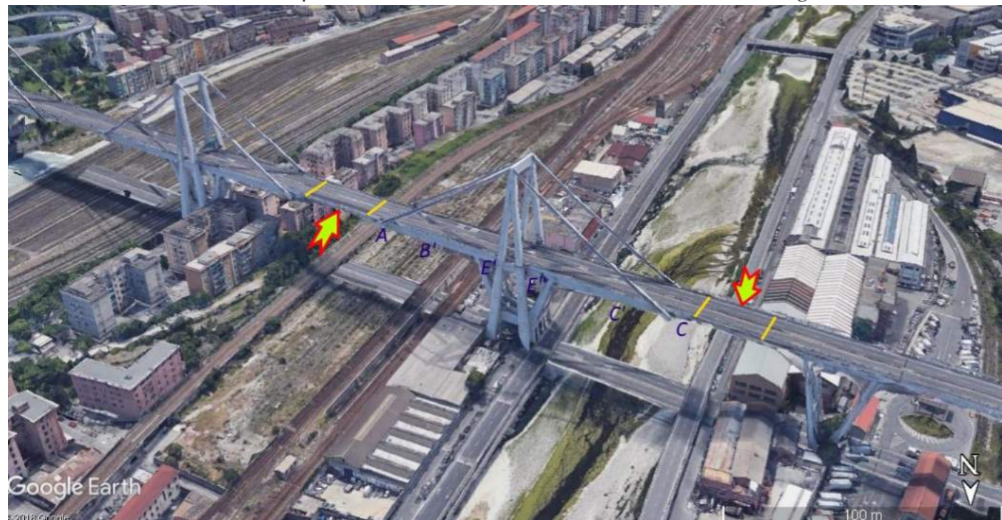
Con linee gialle, le "selle gerber"; con frecce rosse-gialle, le "travi tampone"; con lettere, i punti di rottura dell'impalcato
