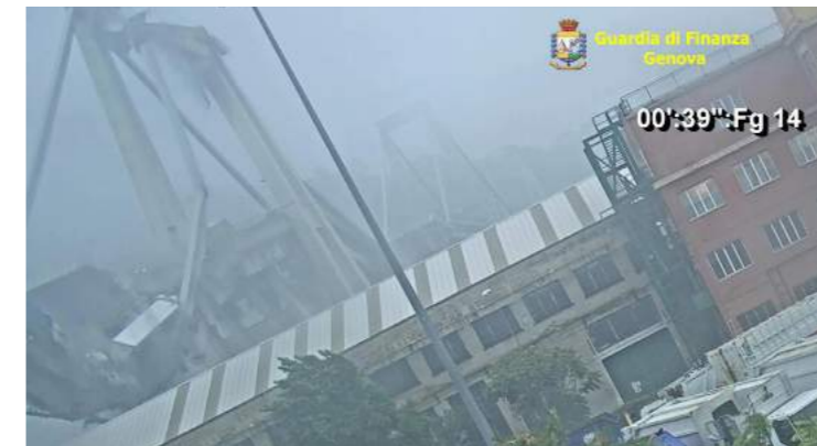
Foto 20. Abbassamento improvviso ed uniforme di tutto l'impalcato
