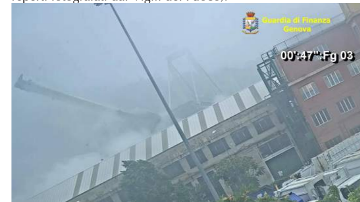
Foto 41. Pilastro sud in caduta con plinto di base
