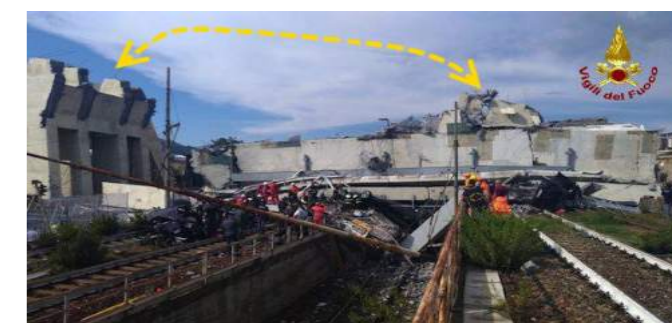
Particolari della parte di trave a cassone finita sottosopra: ossia ruotata di 180° attorno all'asse trasversale del viadotto.
