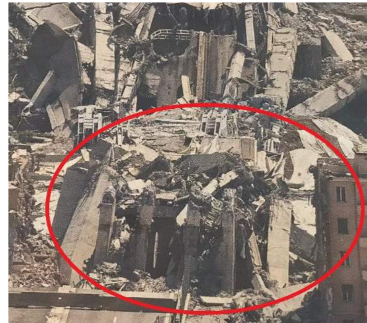
Foto 47. Saeette dopo la demolizione con esplosivo il 28-06-2019
