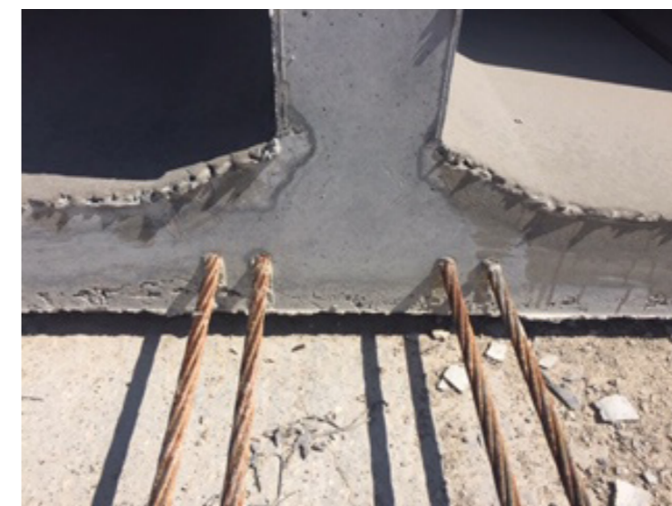
Fig. 13 - Dettaglio dei trefoli sulla testata di una trave a "I" – Rif. Prefabbricati Pugliesi Srl
