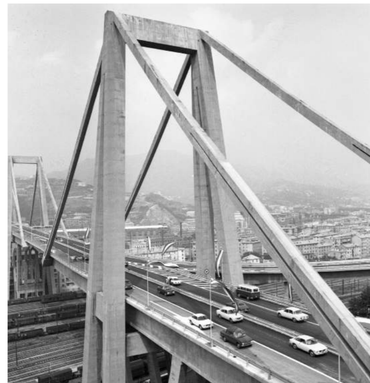
Foto 12. Strallo attaccato in alto sul traverso
