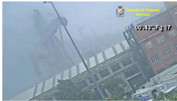
Foto 33. Caduta antenna nord e strallo nord ovest sempre dietro l'antenna sud ed in parte trasparente
