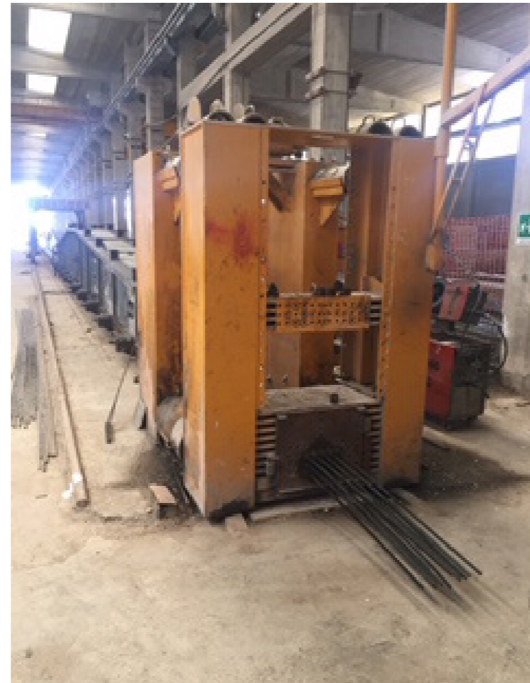
Fig. 11 - Nella foto è riportata la pista delle travi a doppia pendenza con i trefoli tesati a 13500 kg/cmq – Rif. Prefabbricati Pugliesi Srl
