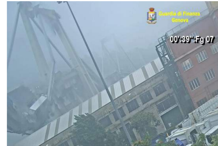
Foto 19. Vista generale impalcato al fg 7, prima che si abbassi improvvisamente ed uniformemente al successivo fotogramma 20
