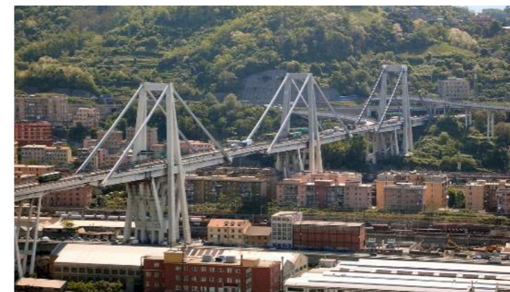
Fig. 4 - Vista di insieme del ponte sul Polcevera - Rif. Wikipedia
