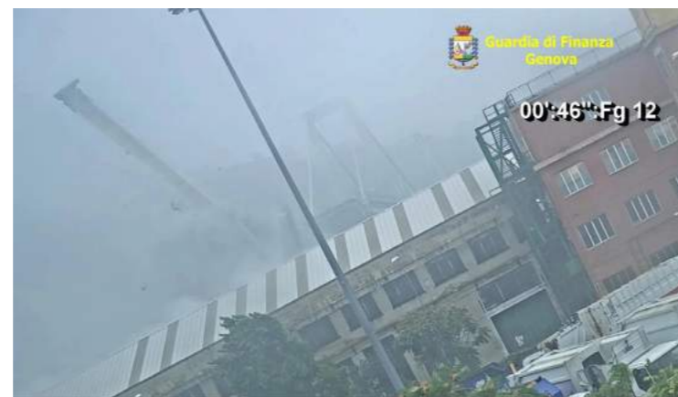
Foto 38. Pilastro appare spezzato e forma un angolo di circa 10° con la base
