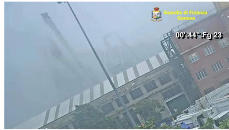
Foto 36. Rotazione pilastro sud
