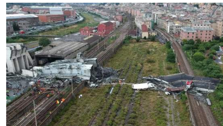
Fig. 29 - PILA 9 - del Ponte sul Polcevera di Riccardo - collassata il 14/08/2018- Rif. controradio.it
