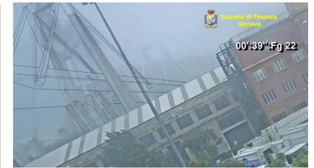
Foto 21. Strallo nord-ovest allungato di 40 metri
