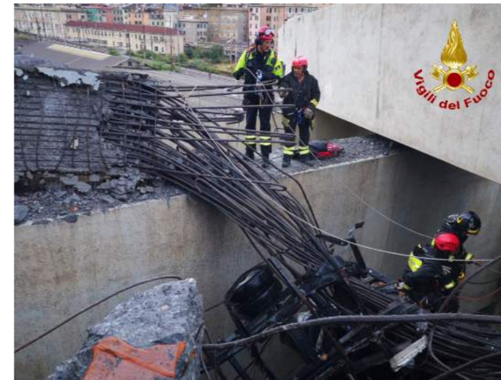
Foto 28. Armatura in ferri di acciaio ancora integri
