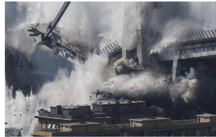
Foto 48 Demolizione del 28-06-2019: gli stralli hanno resistito fino all'ultimo
