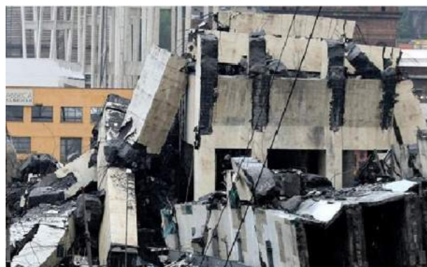
Foto 6. Attacco pilastri obliqui e varie parti annerite
