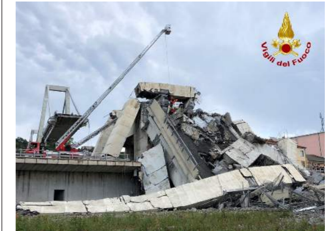
Foto 31. Impalcato ovest con soprastante reperto 132 e tratto di antenna
