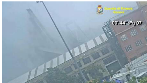
Foto 35. Scomparsa improvvisa antenna nord
