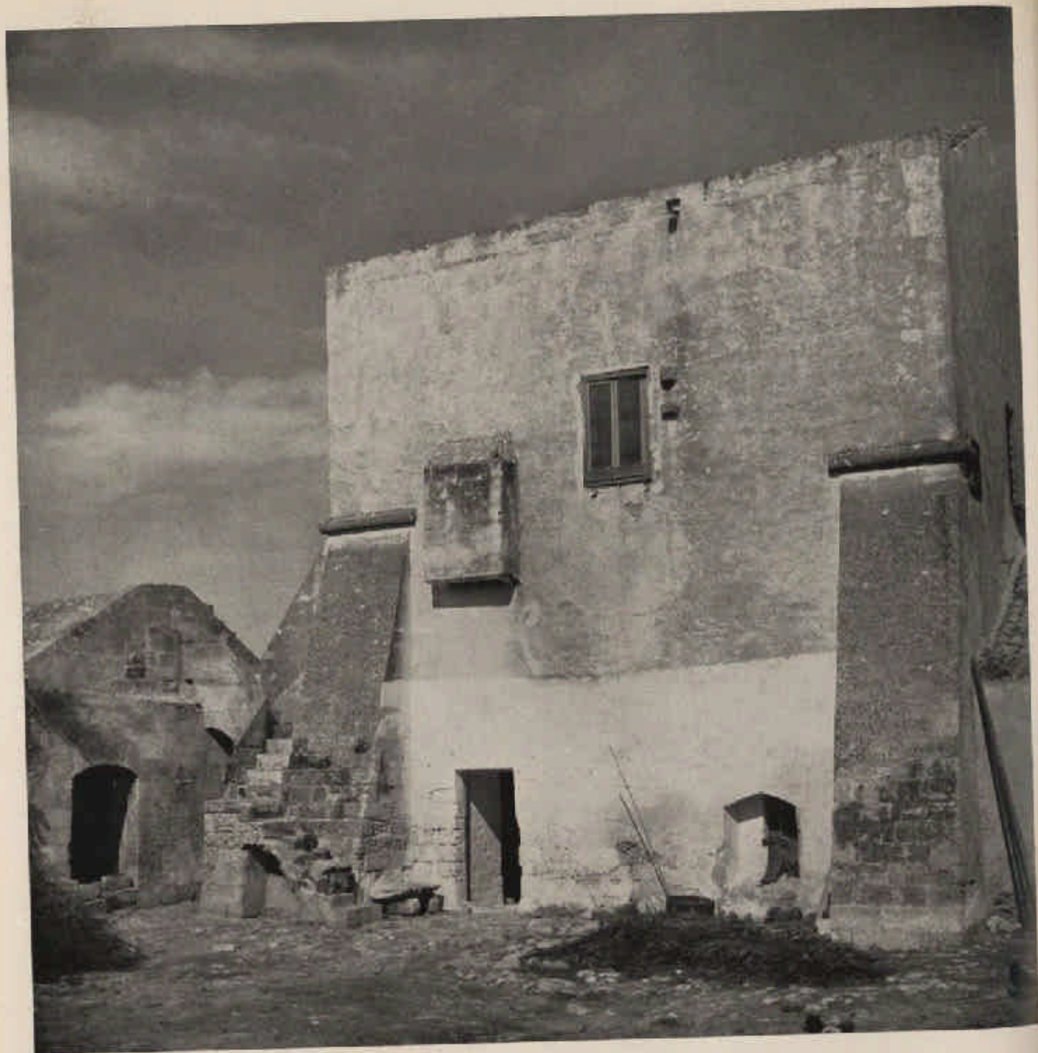
100XXII - PIOMBATOIO E MURO A SPERONI DELLA MASSERIA PRECEDENTE
