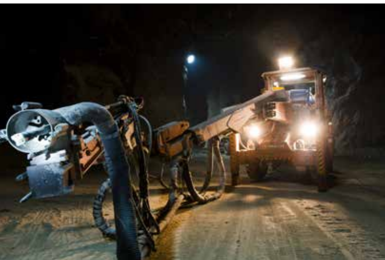
2.25 Cava San Pietro-PratoNuovo, macchina escavatrice (foto: Sandro Gennaro)
