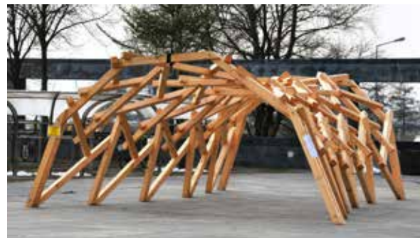
3.20 Arco/Tunnel realizzato con struttura reciproca lignea. Progetto di Annette Spiro, ETH Zurich
