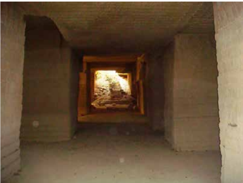
0.5 Cava dismessa di pietra calcarenitica a Canosa di Puglia (BT). La foto è stata scattata dalla galleria principale, dalla quale si diramano le gallerie secondarie.
