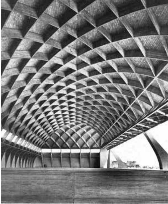
3.7 Pier Luigi Nervi, Hangar a Orvieto, 1935 (fonte: Archimaps)
