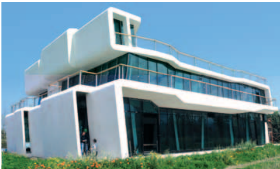
Nuovi uffici della Simone Gatto Sas , Milazzo, Messina, 2005. Vista esterna
