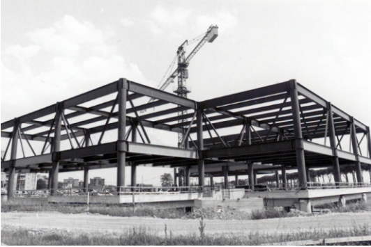
Museo Pecci: cantiere e stato di fatto.
