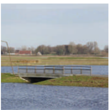
▲ Ruimte voor de Rivier Noordward (West 8 + ipv Delft, 2006 - 2015)
