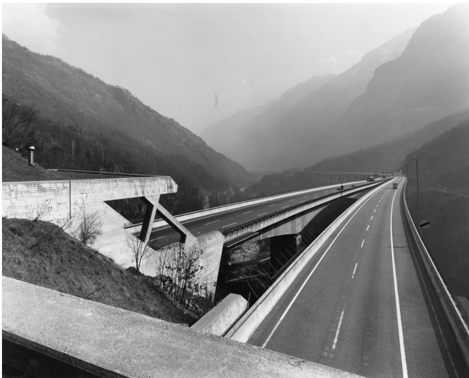
▲ Rino Tami, spalla nord del viadotto della Biaschina, autostrada N2 Chiasso - San Gottardo, 1975 (Archivio del Moderno, Mendrisio, Fondo Rino Tami)
