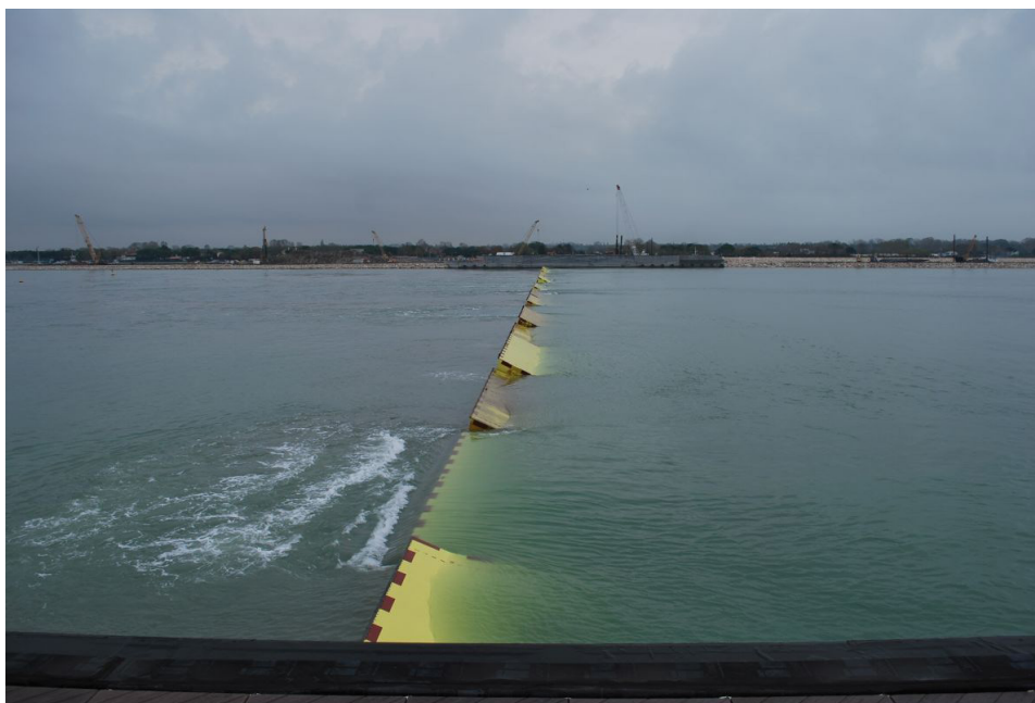
▲ Consorzio di Venezia, MOSE (Modulo Sperimentale Elettromeccanico, Venezia, 2003- (foto di MOSE)
