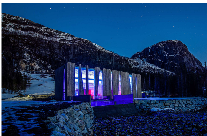
▲ Stein Hamre Arkitektkontor e As, centrale idroelettrica di Helgeland, 2014 (foto di Bjorn Leirvik)
