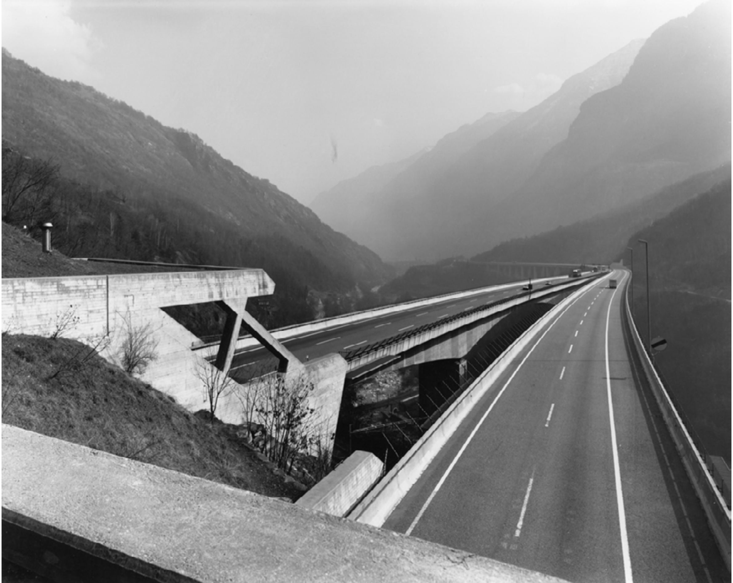
Spalla nord del viadotto della Biaschina, autostrada N2 Chiasso - San Gottardo Rino Tami 1975 © Archivio del Moderno, Mendrisio, Fondo Rino Tami
