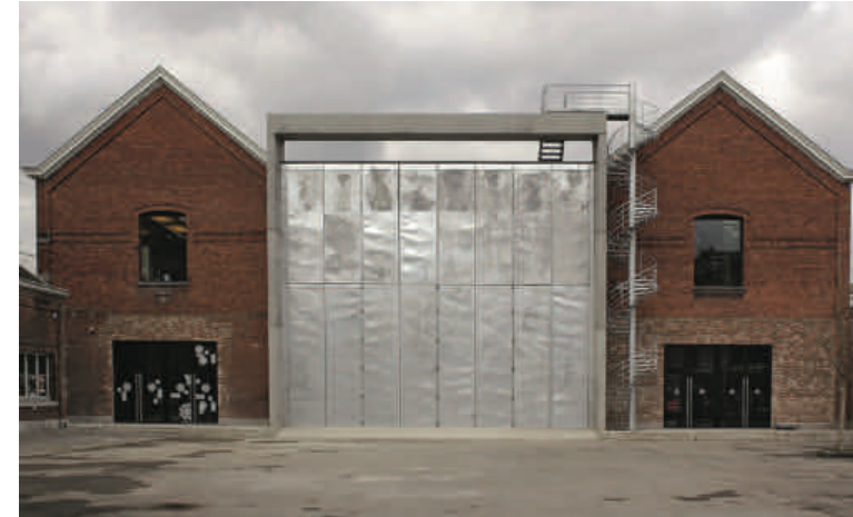
3.33 Mons, Maison Folie, Vista esterna del nuovo intervento.
