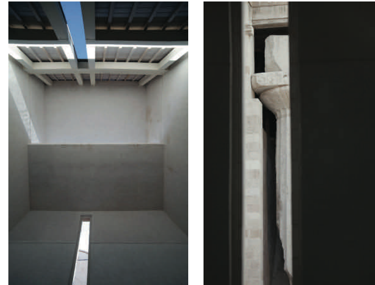
3.107 Padiglione di accesso agli scavi del tempio di Artemide a Siracusa, Cavedio di luce interno.
