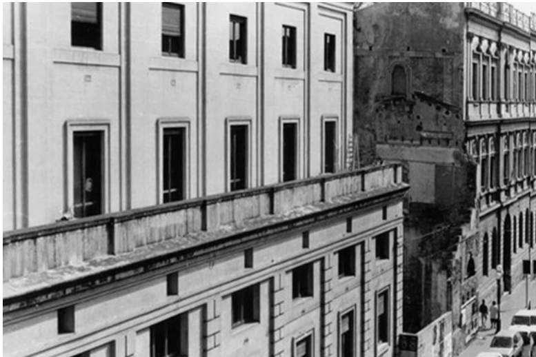
3.104 Siracusa, Piazza Minerva, Edifici comunali e discontinuità dei fronti murari prima del padiglione di V. Latina.
