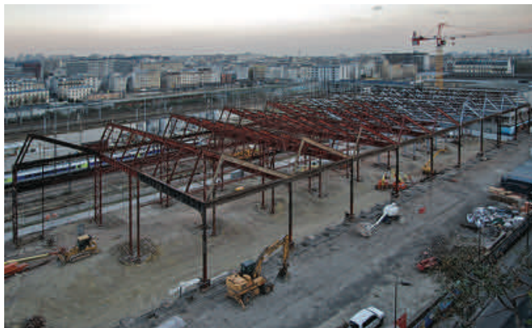
3.51 Parigi, Quartiere La Chapelle, Struttura portante del magazzino ferroviario preesistente.
