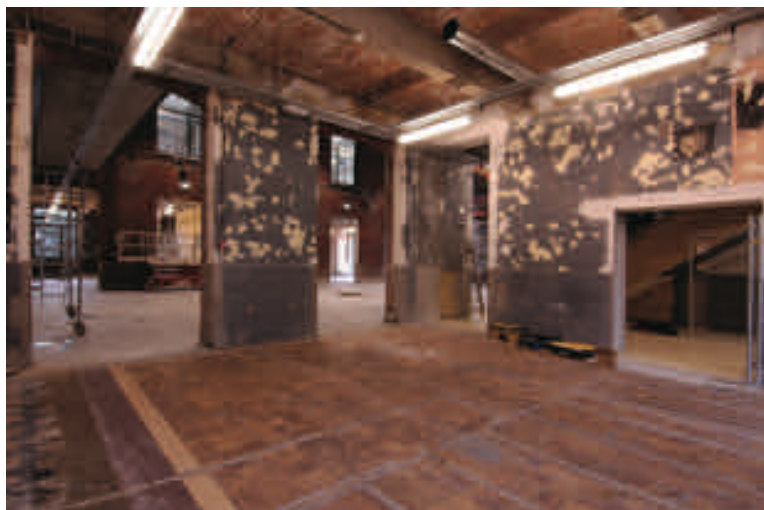
3.34 Mons, Maison Folie, Vista interna di uno dei due corpi preesistenti verso lo spazio centrale.
