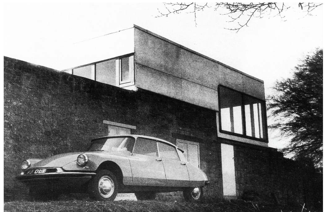
1.10 Fonthill, Upper Lawn Solar Pavilion, Vista dalla strada
