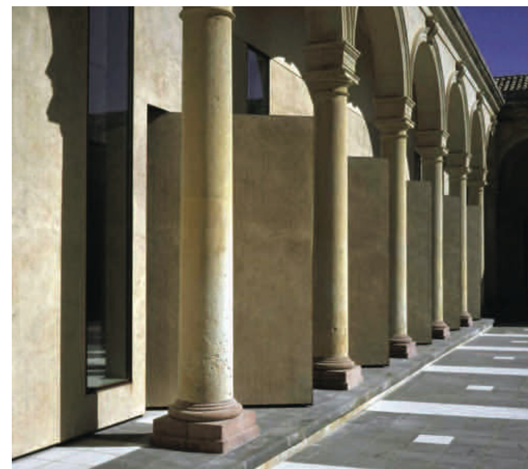
3.101 Corte interna all'ex Mercato Coperto di Ortigia, Siracusa, Vista verso la sala polivalente.
