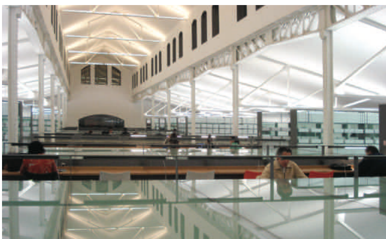
3.23 Madrid, Casa del Lector al Matadero, Vista interna complessiva al livello delle travi-ponte.
