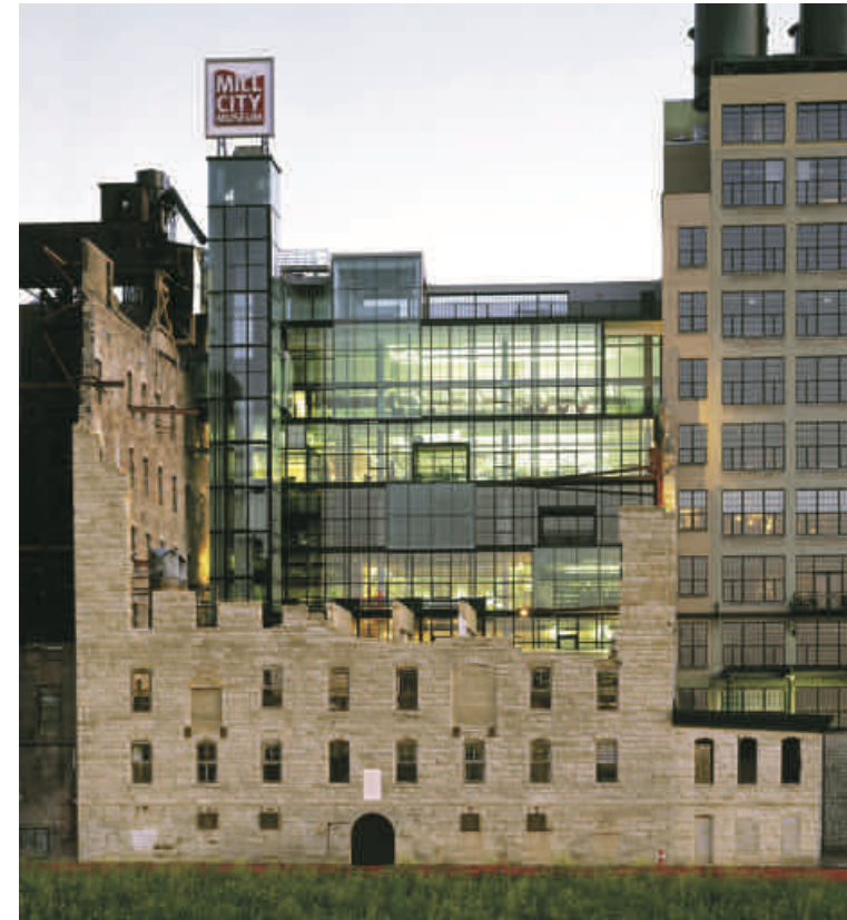
3.91 Minneapolis, Mill City Museum, Vista frontale dal fiume.
