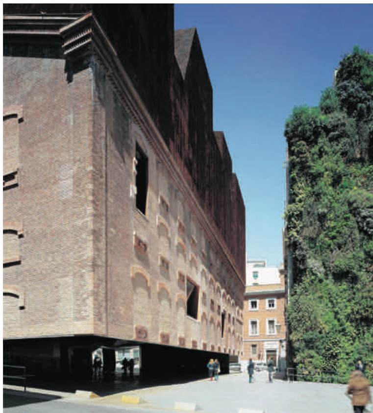
3.58 Madrid, Caixa Forum, Continuità fra la piazza coperta e la piazza scoperta.
