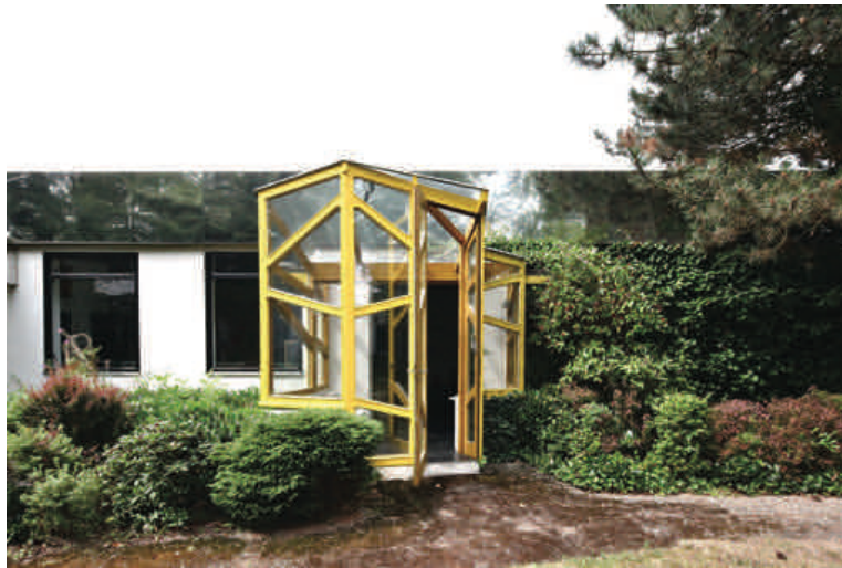
1.14 Lauenförde, Fabbrica TECTA, Veranda verso la corte interna
