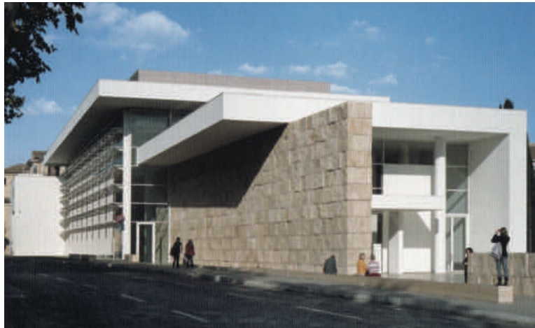
3.6 Roma, Il fronte ovest del museo di Meier dal lungotevere, Dettaglio del muro e della vetrata.
