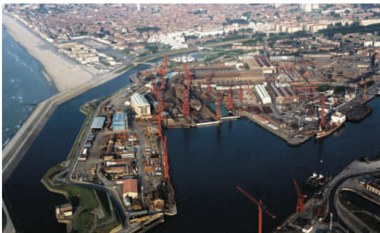
3.43 Dunkerque, Porto prima del 1988, Vista aerea.
