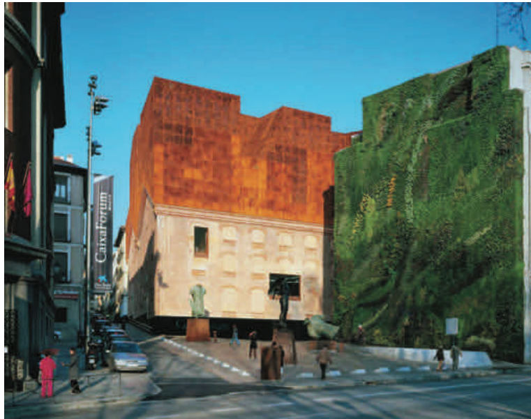
3.57 Madrid, Caixa Forum, Vista della piazza scoperta e del giardino verticale.
