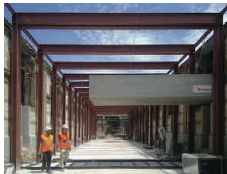
3.20 Madrid, Casa del Lector al Matadero, Passaggio di una trave-ponte tra i due padiglioni durante il cantiere.
